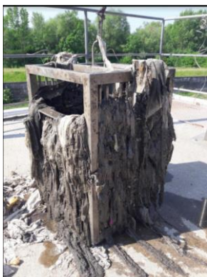
stav koša pri príchode O.Frišloviča na ČOV. Bežná situácia.
